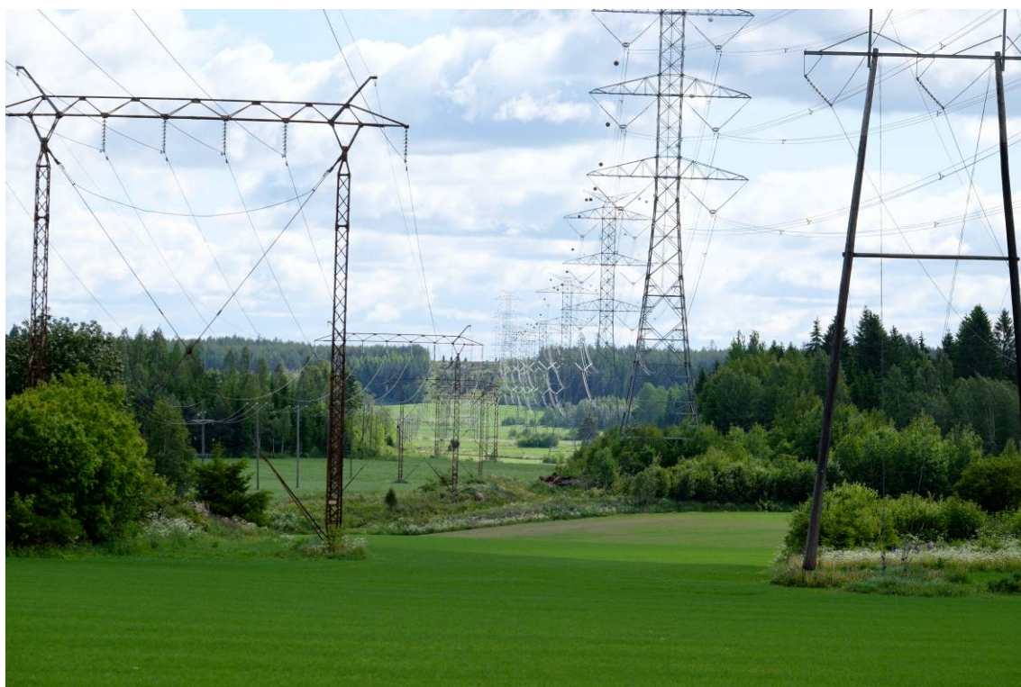
Voimalinjaa Hikiällä, osa c-d, kuva lännestä. (AKDG4268:3)
