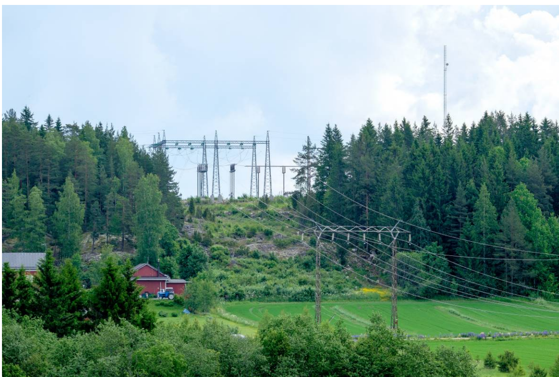
Purettavaa voimalinjaa Orimattilan Viikarin sähköaseman länsipuolella, kuva lännestä. (AKDG4268:7)
