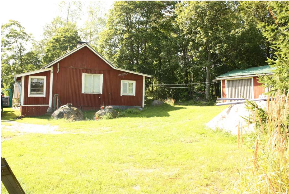
Kuva 2. Granuddin vanha päärakennus ja piha, kuvattu idästä. AKDG 4608:1
