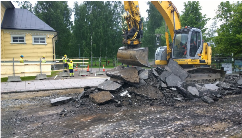
AKDG 4499:8. Asfalttia poistetaan ja työmaa-aitaa rakennetaan, etelään. Kuvaaja: P. Pesonen.
