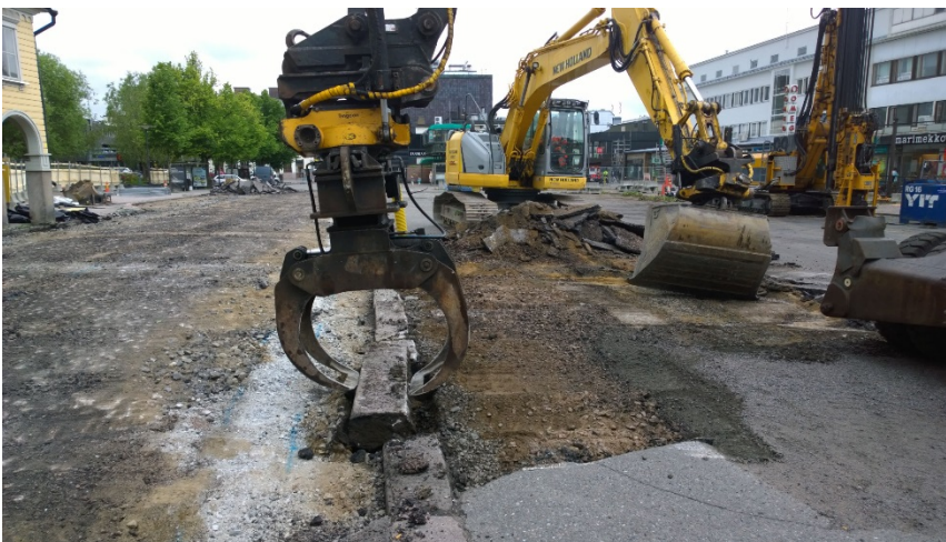
AKDG 4499:18. Asfalttia ja reunakiviä poistetaan Valtakadun työmaan itäpäässä, lounaaseen. Kuvaaja: P. Pesonen.
