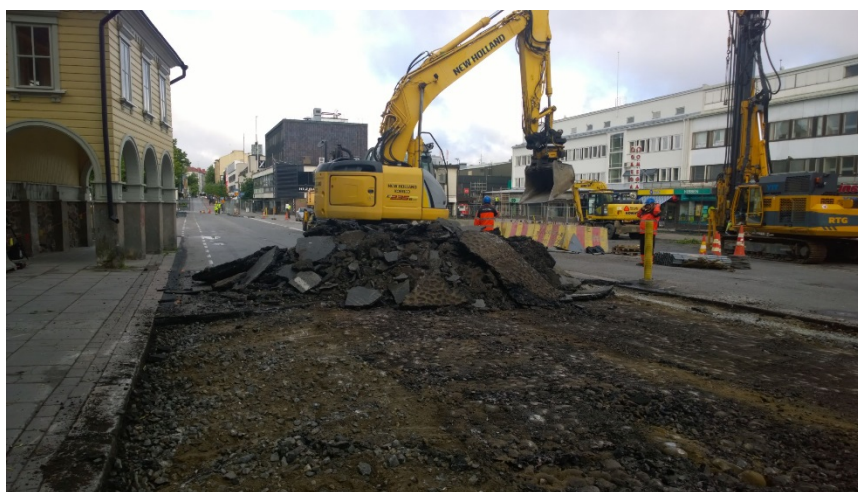
AKDG 4499:3. Mukulakiveystä asfaltin alla, länteen. Kuvaaja: P. Pesonen.
