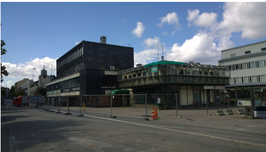
AKDG 4499:27. Yleiskuva myöhemmin purettavasta vanhasta linja-autoasemasta ja sen vierellä olevasta talosta. Kuvaaja: P. Pesonen.
