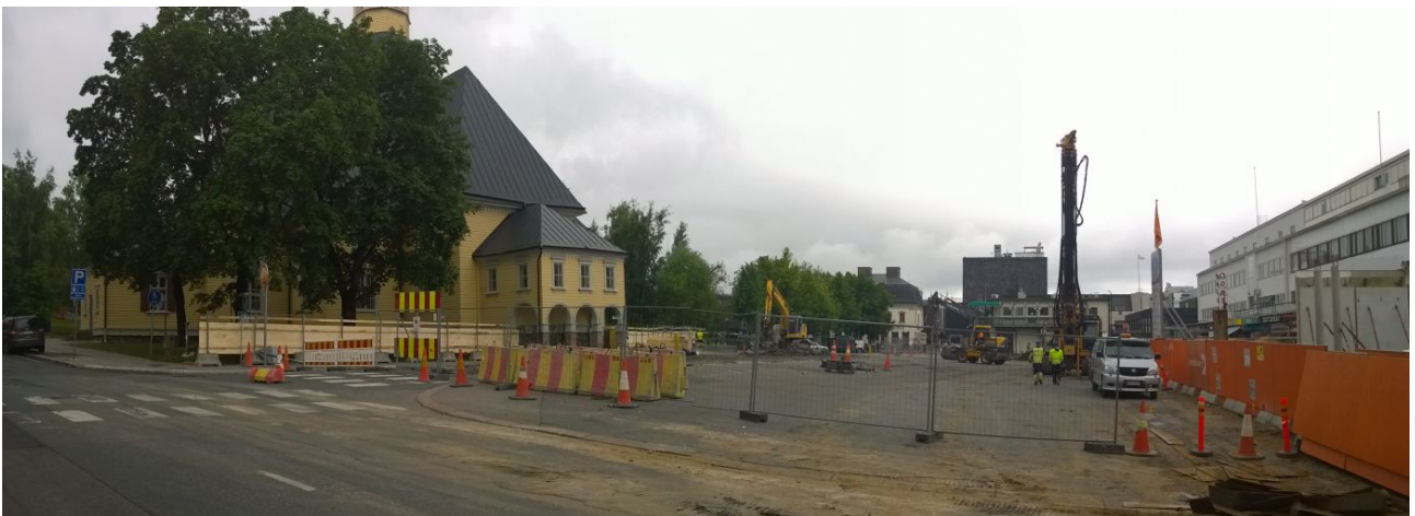
AKDG 4499:9. Marian aukion työmaa, lounaaseen. Kuvaaja: P. Pesonen.
