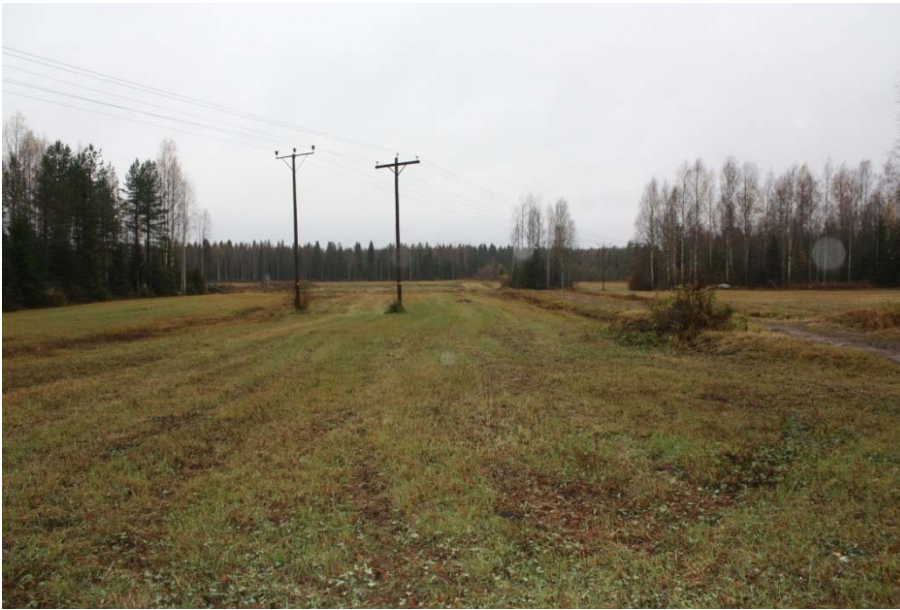
AKDG 3877:12. Voimalinja Suomelan autiotalon luona, jossa suunniteltu kaapelilinjaus kulkee heinäpeltojen halki vaihtoehdossa 2, pohjoisesta. Kuvaaja: P. Pesonen.
