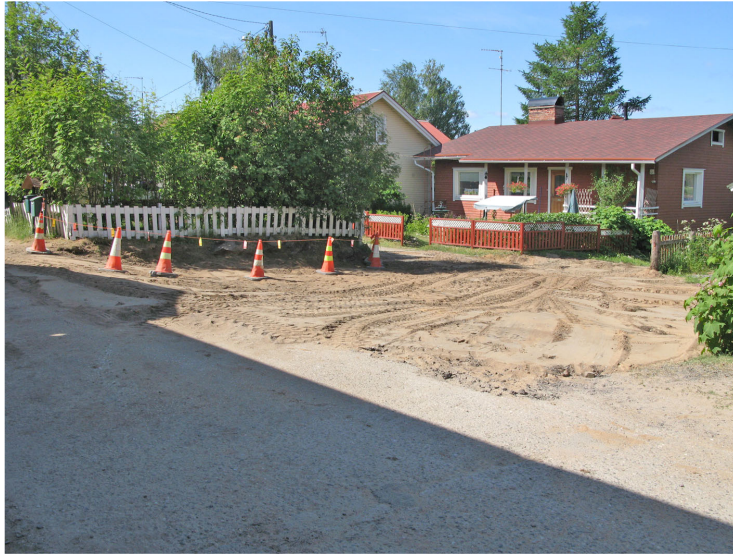
Kuva 5. Kaivausalue C tutkimusten jälkeen peitettynä. Kuvaussuunta länteen.
