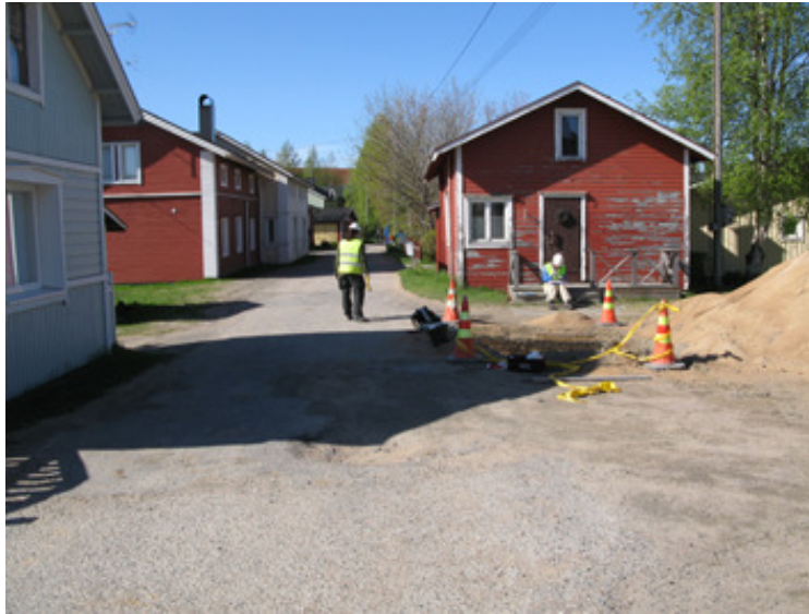
Kuva 2. Koeoja B:n sijainti Ylä- ja Alakadun risteyksessä. Taustalla Yläkatu 16 rakennus.
