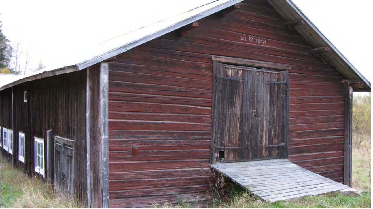
DG 266:1. Vahijärvi (Wahajärfvi). Vanha aittarakennus. 13.10.2008.
