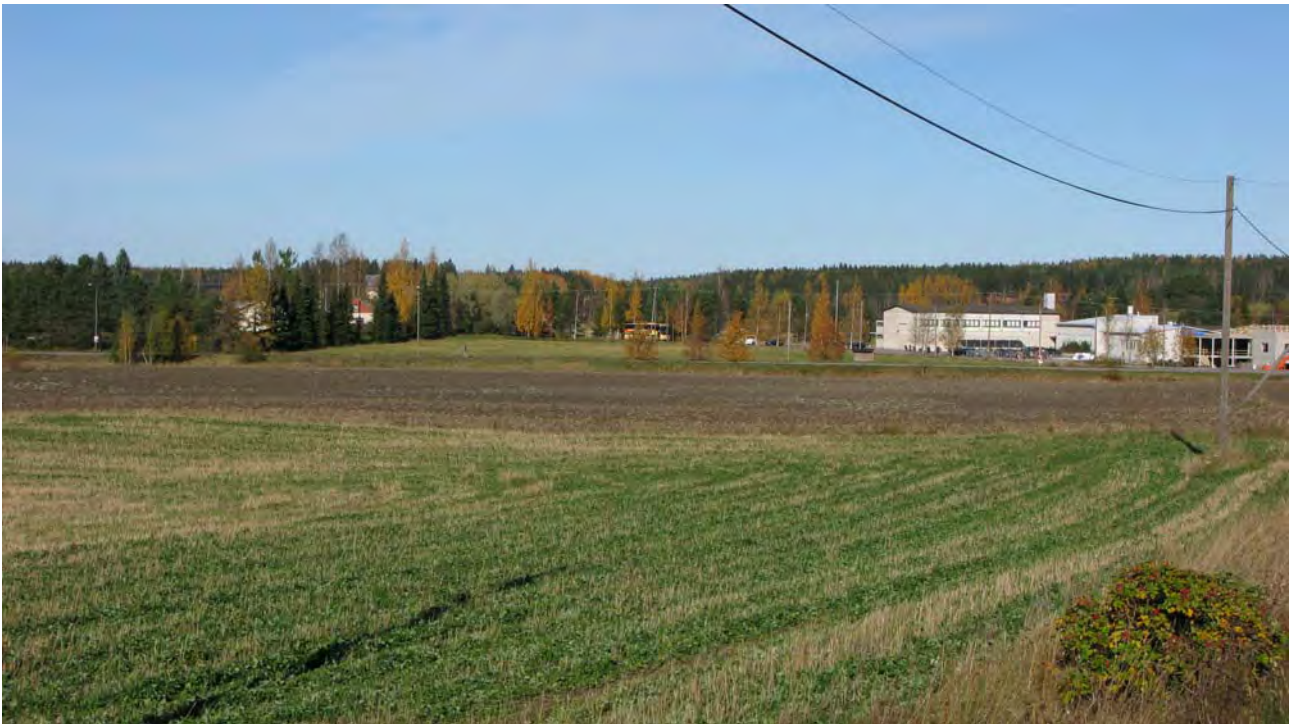
DG 250:1. Uusi-Klemetilä. Asuinpaikka kuvaa lähimpänä olevalla kynnöllä, taustalla yläasteen rakennustyömaa, kaakosta. 8.10.2008.
