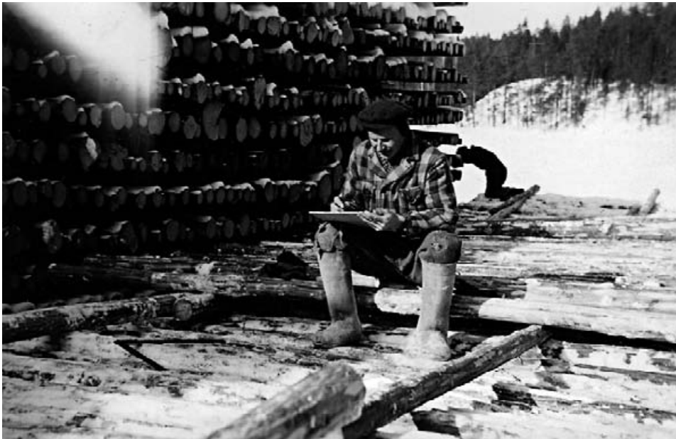
Kuva 50. Kuvassa Oiva Pyy vastaanottamassa tukkilasteja ja kirjuriina Ylätervajärven rannalla. Työnjohtajana toimi Jaakko Outinen.
